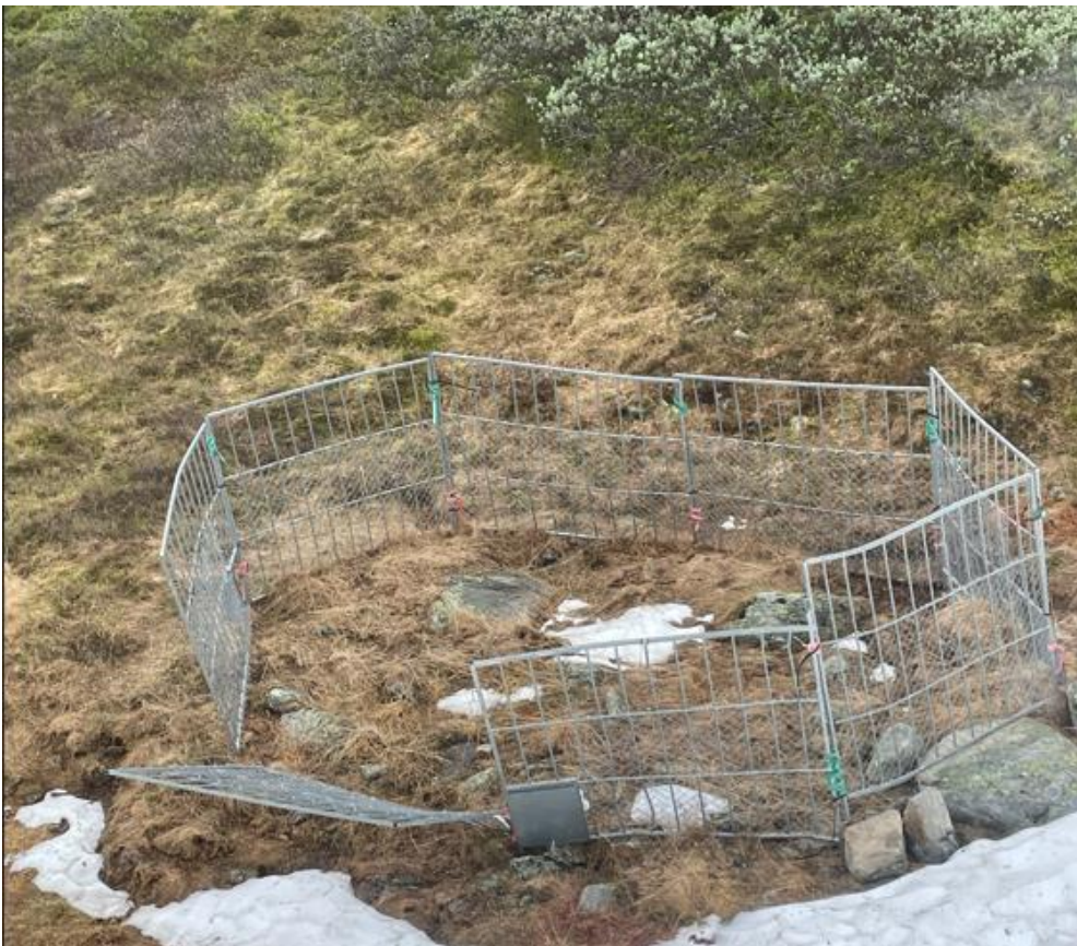
Bilde 2: Grindanlegg med ødelagte stropper og løs grind.
