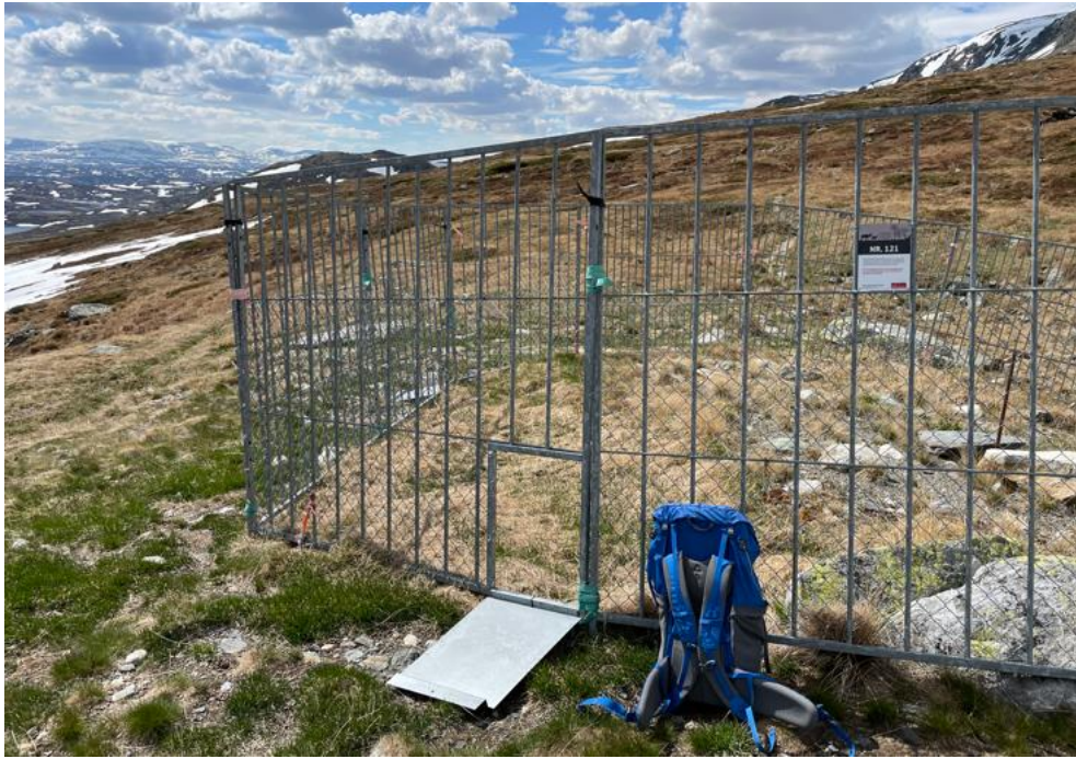
Bilde 3: Grindanlegg i Nordfjella-sonen. Her har stålplata som dekker åpningen som var laget for at sau kunne gå ut og inn av grinda, løsna i løpet av vinteren. Disse åpningene i grindene ble stengt våren 2019 etter at det var dokumentert at også rein og hjort tok seg inn i grindanleggene gjennom åpningene.
