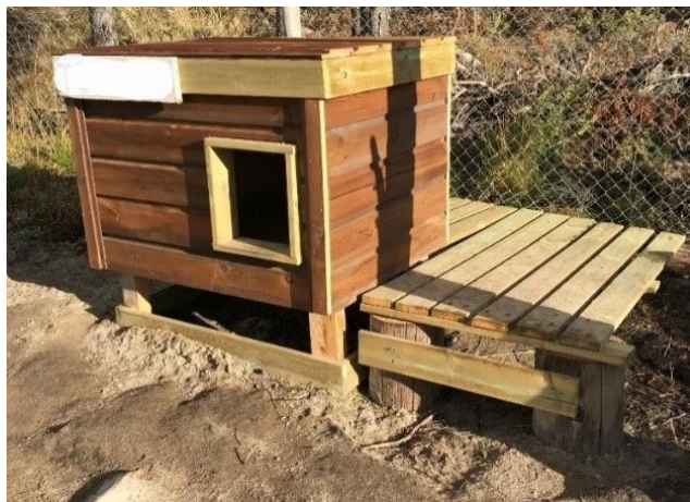
Bilde 4: Dette er et eksempel på en godt konstruert oppholdsplass. Huset er hevet opp fra bakken, det har flatt tak og en hevet plattform som hunden kan ligge på. Åpningen til huset er ikke for stor, og den er plassert til den ene siden. Slik får hunden et lunt innemiljø. Foto: Mattilsynet
